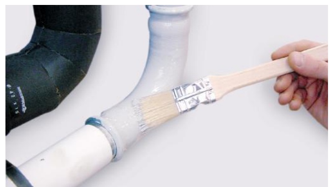
Afbeelding 37 – Schilderen fittingen en buizen met primer
